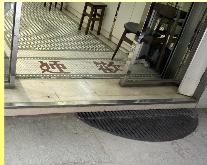
位於店舖門口的半圓形通風口 Semi-circular air vent at shop entrance
